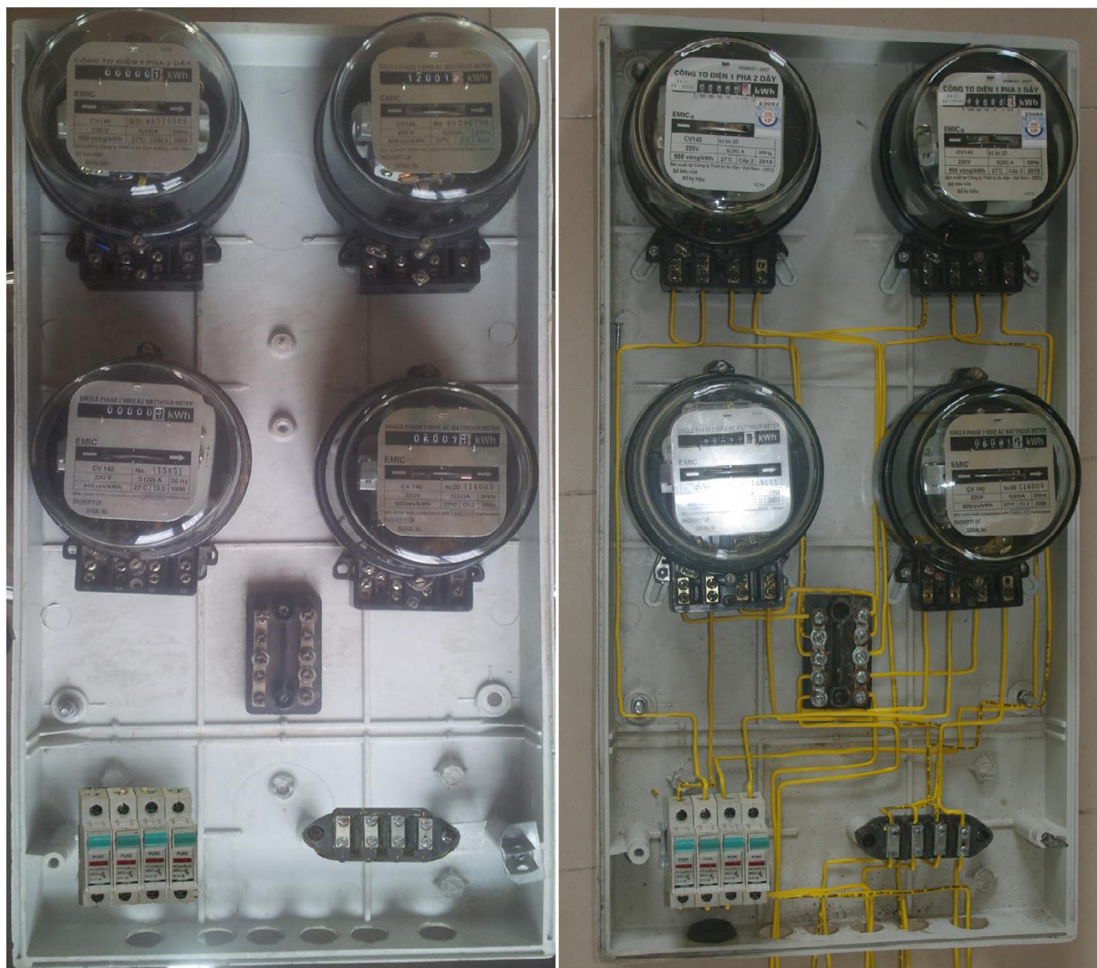
Hình 4-15: Lắp thiết bị và đấu dây hòm công tơ
